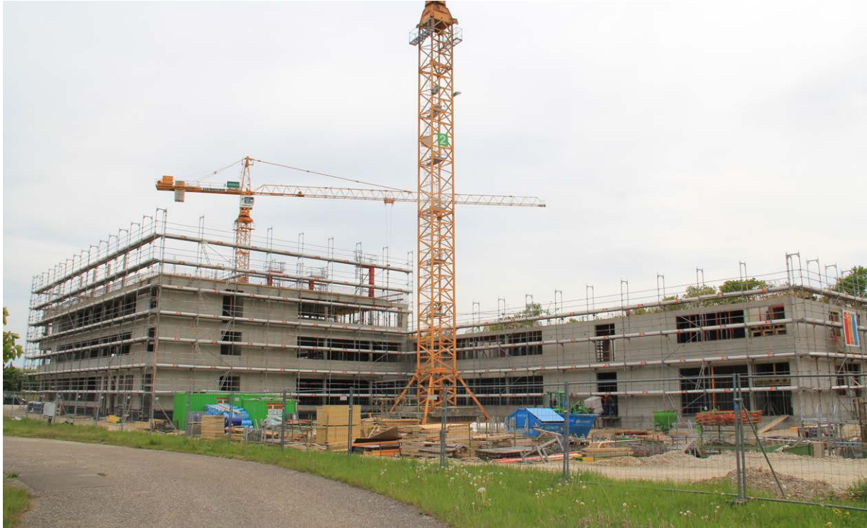
Rohbauarbeiten am neuen Firmengebäude für Kayser-Threde in Oberpfaffenhofen bei München
